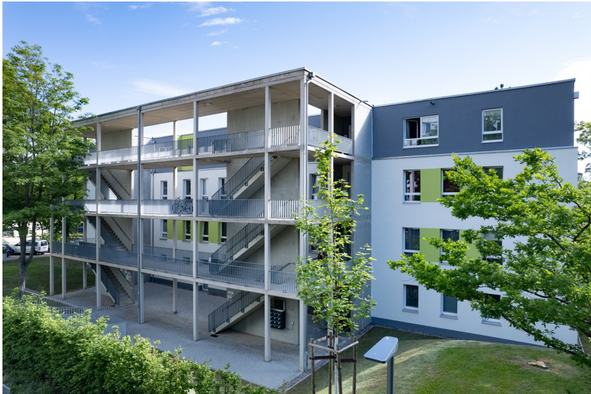
Abbildung 99 Außenansicht Erfurt BSZ. [© BBSR/BILDKRAFTWERK/Peter-Paul Weiler]
