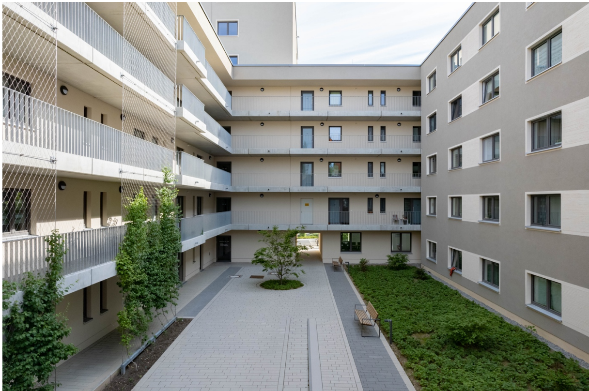
Abbildung 21 Blick in den Innenhof, Jena. [© BBSR/BILDKRAFTWERK/Peter-Paul Weiler]
