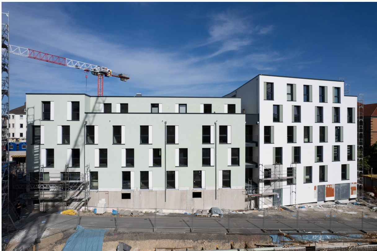
Abbildung 158 Außenansicht Kassel. [© BBSR/BILDKRAFTWERK/Peter-Paul Weiler]
