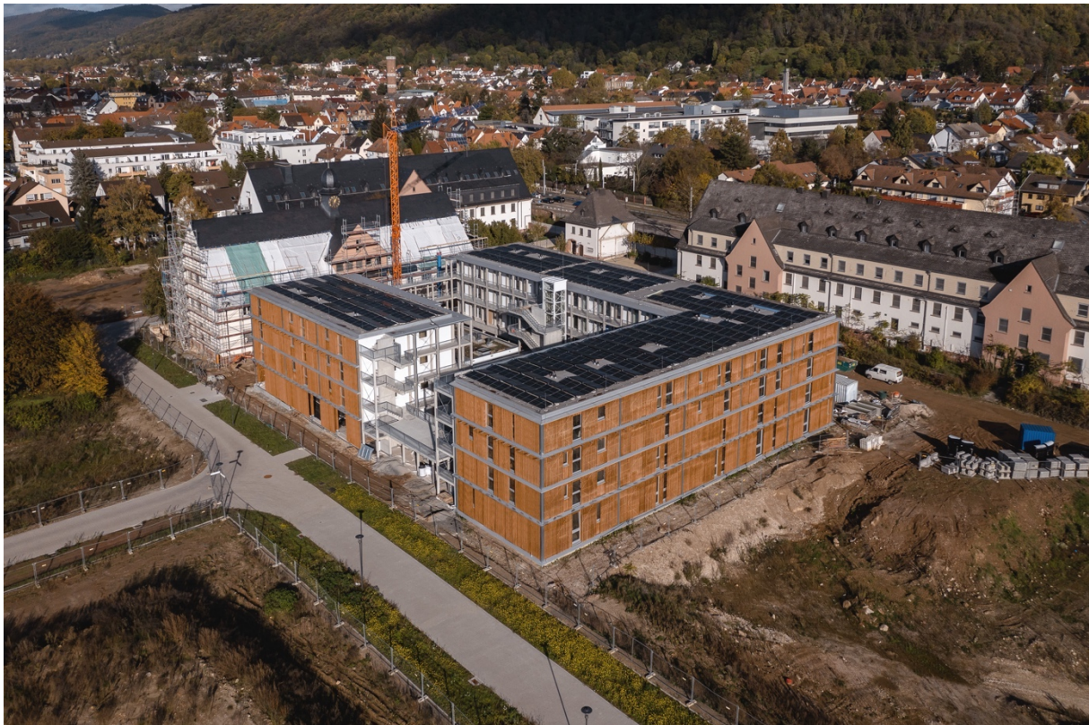
Abbildung 137 Außenansicht Collegium Academicum mit Laubengangerschließung im Innenhof, November 2022. [© Thilo Ross Urh. Nr. 4026999 / Quelle: DGJ Architektur]
