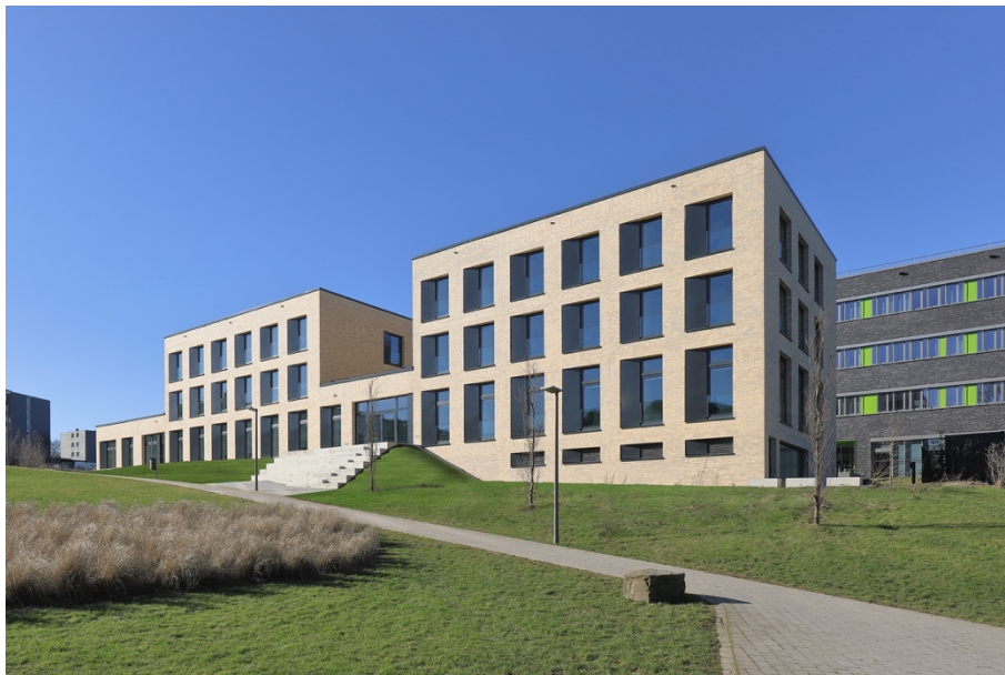
Abbildung 51 Außentreppe zum Park in Heiligenhaus. [© Hans Jürgen Landes, Dortmund]
