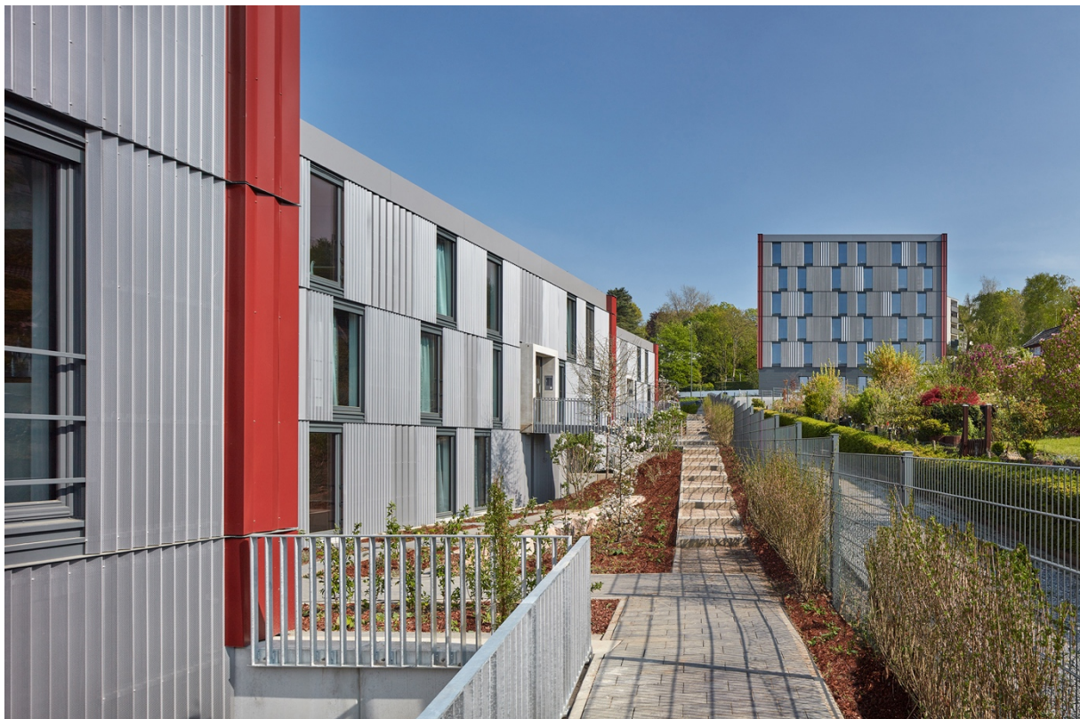
Abbildung 185 Außenraumgestaltung Wuppertal. [© Sigurd Steinprinz/ACMS Architekten GmbH]
